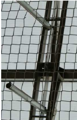
Durchtrennte Litze für Zylinderöffnung
